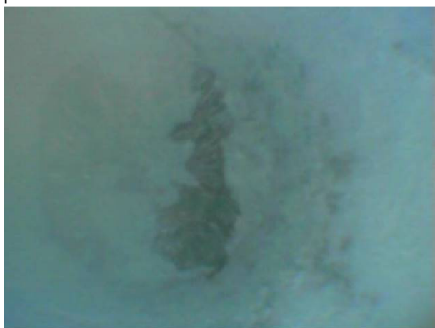
Kanálek 4 - 1 x drát proinjektovaný, bez koroze.
