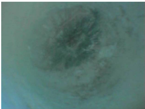
Kanálek 1 - 2 x drát proinjektovaný, mírná povrchová koroze.
