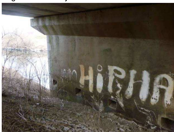
Podpěra P3 je silně zatečená, viditelná degradace omítky.
