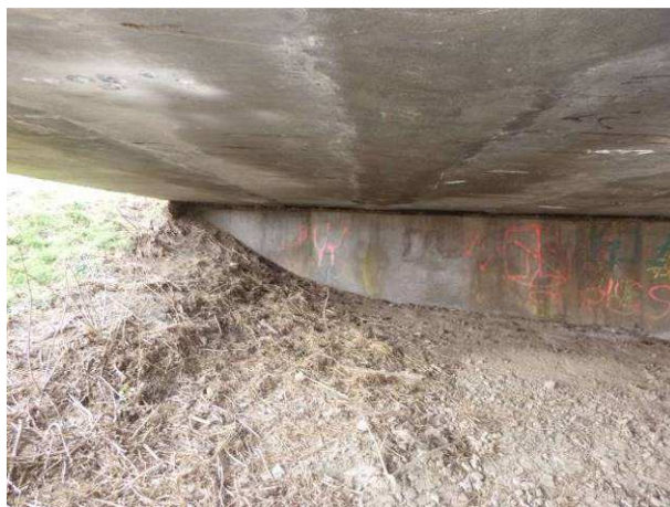
Opěra je opatřena omítkou tloušťky 15 – 25 mm.
