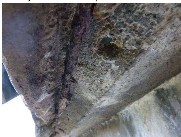
Pohled na korodovanou výztuž pravé římsy a degradovaný beton.
