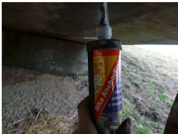
Zapravení navrtávky dvousložkovou epoxidovou pryskyřicí.
