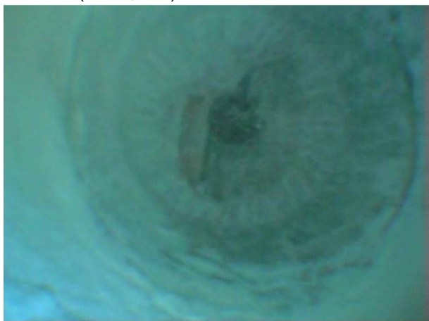
Kanálek 1 – 2 x drát proinjektovaný, mírná povrchová koroze. (řez 6,2 m)
