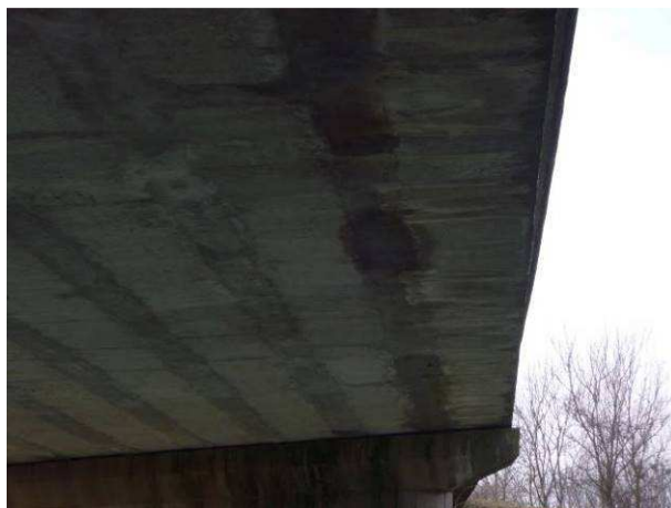
Pohled na zatečenou dobetonávku mezi nosníky 1 a 2 v druhém poli.
