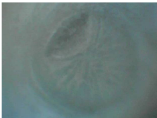
Kanálek 1 - 1 x drát proinjektovaný bez koroze.
