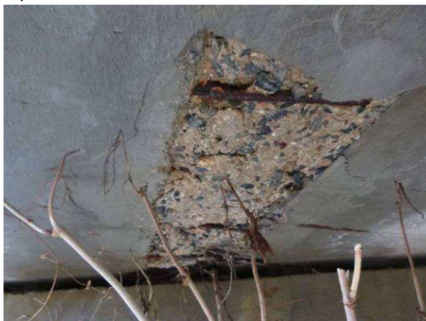
Pohled na degradaci dobetonávky v poli tři u P3. Silná koroze výztuže.
