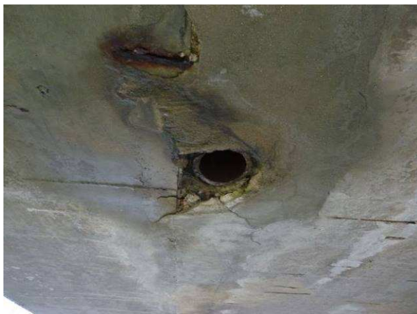
Pohled na degradaci betonu kolem odtoku v poli tři blíže k P3.
