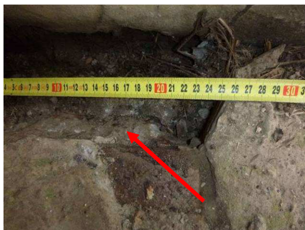
Obnažená kotevní deska, dráty jsou stále chráněny cementovou maltou.
