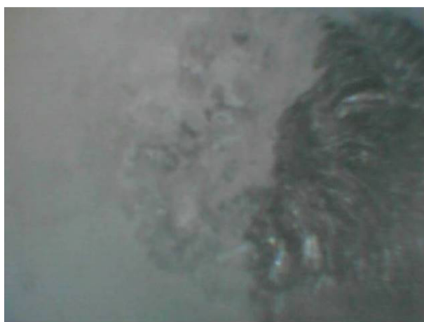
Kanálek 1 – chránička, proinjektovaný, bez koroze.
