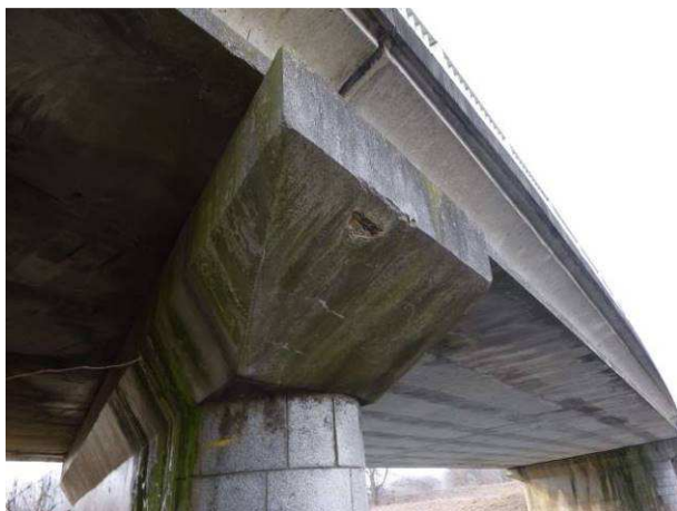
Pohled na zatečenou NK a práh podpory P3.
