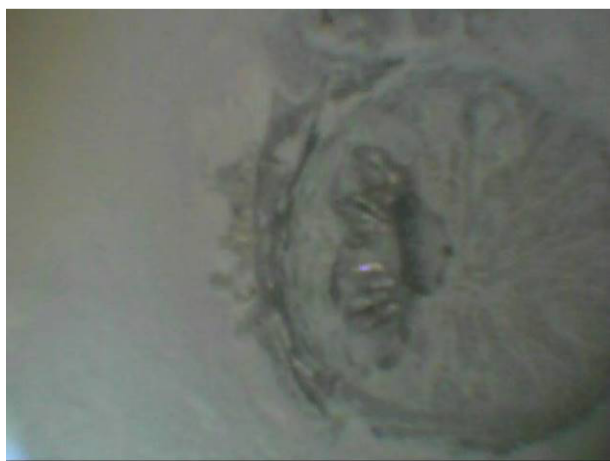
Kanálek 1 - 2 x drát proinjektovaný, bez koroze.
