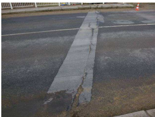
Pohled na podpovrchovou dilataci, kryt vozovky je rozpraskán, silně zdegradovaný.
