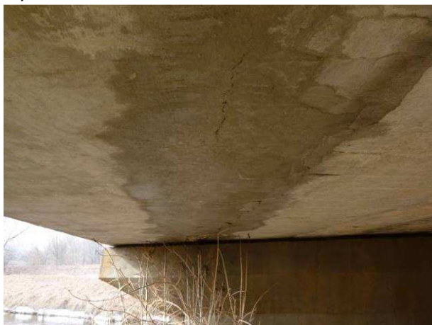
Pohled na silně promáčenou dobetonávku včetně nosníků 7,8 v poli tři.
