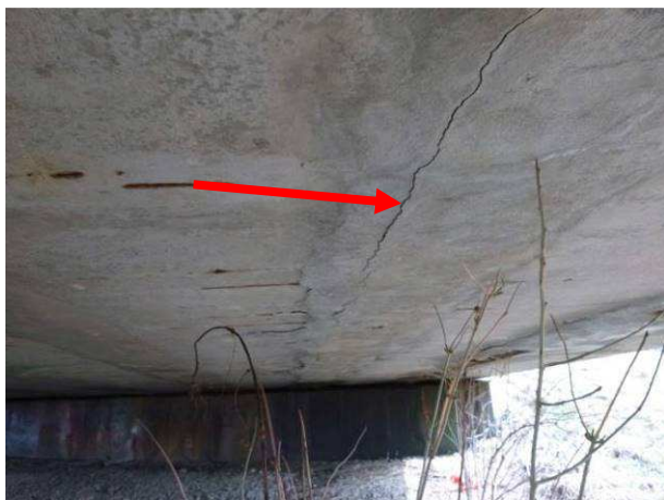
Pohled na podélnou trhlinu v dobetonávce mezi 6-7 nosníkem v poli tři.
