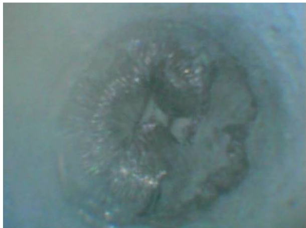
Kanálek 4 – 2 x drát proinjektovaný, bez koroze. (řez 6,2 m)
