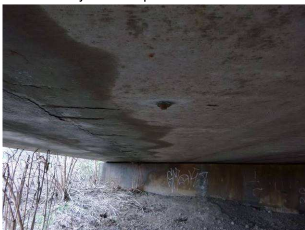
Pohled na silně zatečenou dobetonávku mezi nosníky 7 a 8 v prvním poli.
