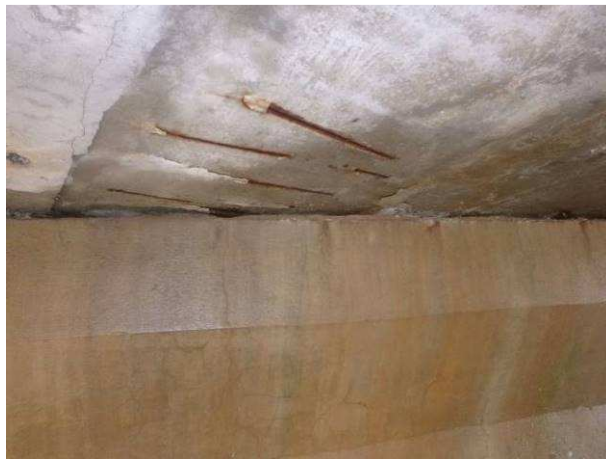
Pohled na zatečený úložný práh, který je omítnutý cementovou maltou.
