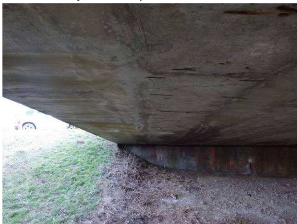
Pohled na výluhy v dobetonávce se zatékání v poli tři.
