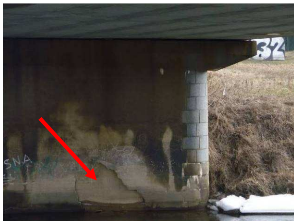
Podpěra je silně zatečená, viditelná degradace omítky.
