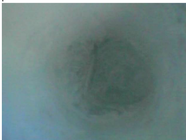
Kanálek 4 - 2 x drát proinjektovaný, bez koroze.
