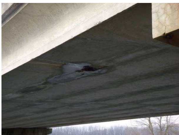
Pohled na zdegradovanou dobetonávku v poli dva mezi 7-8 nosníkem. Svod vody je zkorodovaný a nemá přesah.
