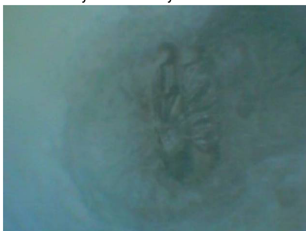
Kanálek 2 - 3 x drát proinjektovaný mírná povrchová koroze.
