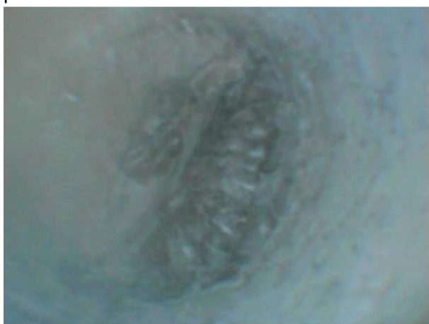
Kanálek 3 - 2 x drát proinjektovaný, bez koroze.
