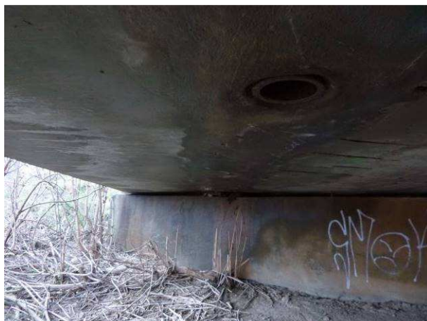
Opěra je také solně zatečená s degradující omítkou.
