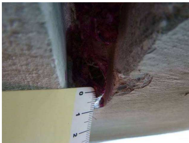
Karbonatace byla naměřena cca 20 mm, celá vrstva omítky, do malé hloubky i s betonem.
