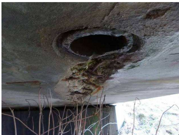
Pohled na zdegradovanou dobetonávku v poli tři mezi 7-8 nosníkem. Svod vody je zkorodovaný a nemá přesah.
