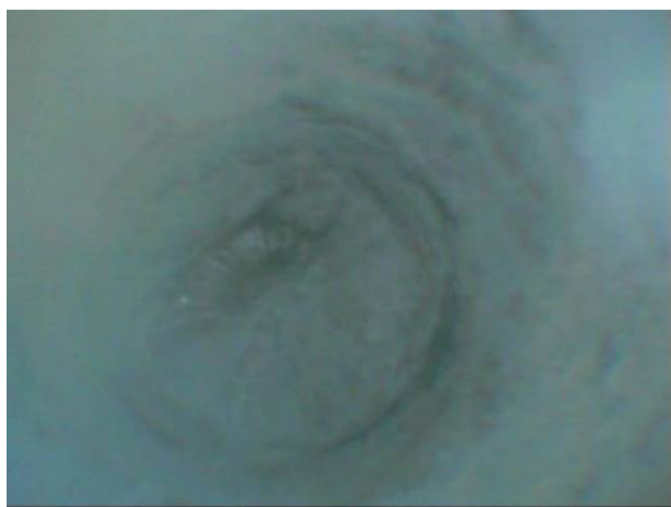
Kanálek 1 - 1 x drát proinjektovaný, bez koroze.
