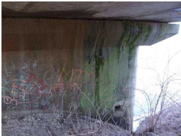
Čela podpěr jsou z kamenného obkladu, práh a dřík podpěry jsou zatečeny.
