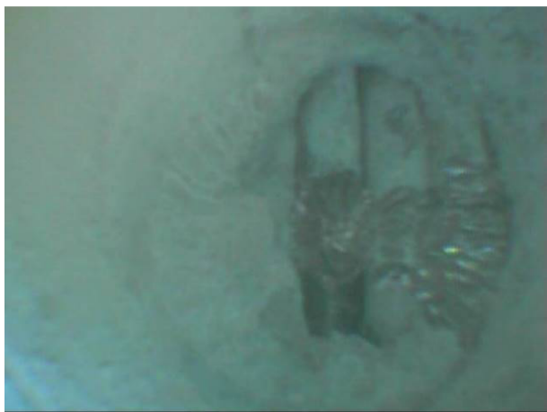
Kanálek 2 - 3 x drát proinjektovaný, mírná povrchová koroze.
