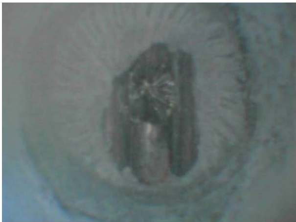
Kanálek 3 – 3 x drát proinjektovaný, mírná povrchová koroze. (řez 6,2 m)
