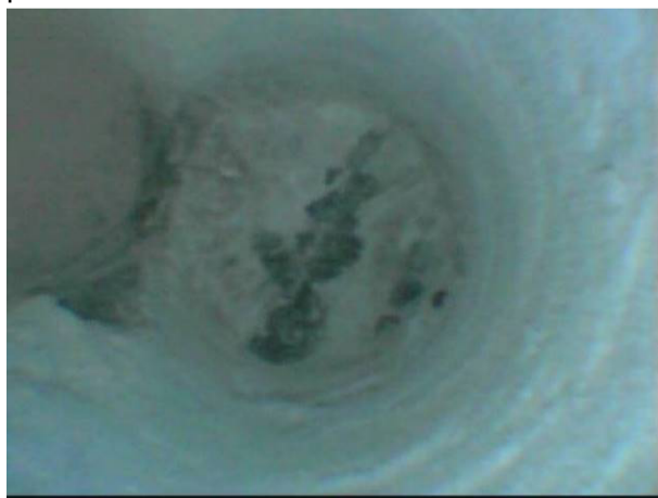
Kanálek 3 - 1 x drát proinjektovaný, bez koroze.
