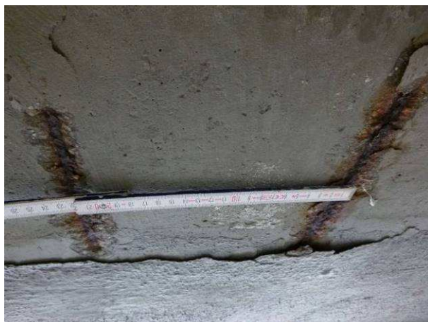
Pohled na korodovanou betonářskou výztuž nosníků I 62.
